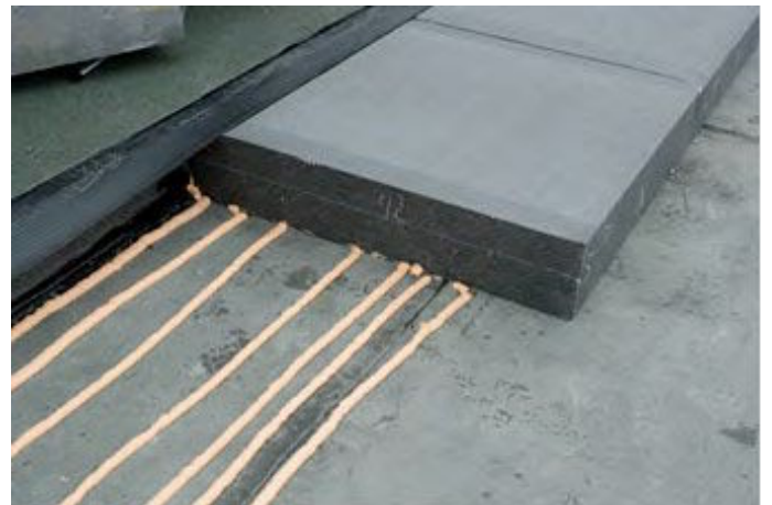
Verlegung von Dämmstoffplatten aus Neopor® beim Bau eines Bürokomplexes in Aachen.
