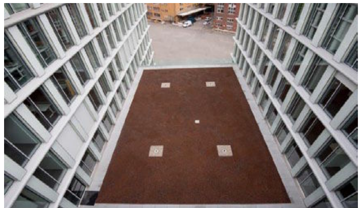
Die Flachdächer des Gebäudes D105 befinden sich auf verschiedenen Ebenen. Hier ein Flachdachbereich auf einer tieferen Ebene zwischen transparent gestalteten Fassaden. Mitarbeiter haben einen schönen Blick auf die später bepflanzten Flächen.
