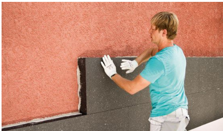
Fachhandwerker beim Anbringen einer Fassadendämmplatte aus Neopor®
