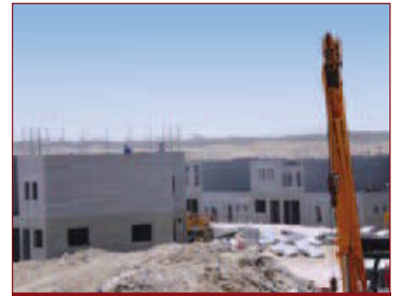
Verarbeitung von Dämmstoffen aus Neopor® in der heißen Sonne Abu Dhabis
