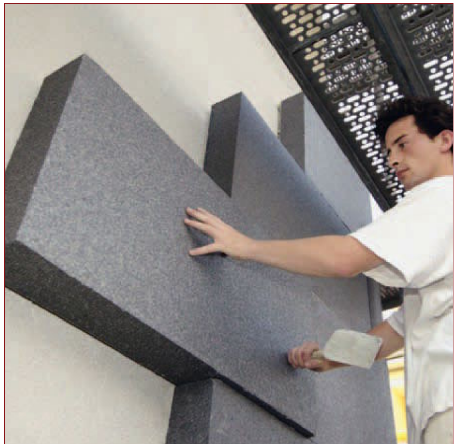
Sicherer Halt der Dämmplatten mit ausreichend Kleberauftrag nach Herstellerangaben
